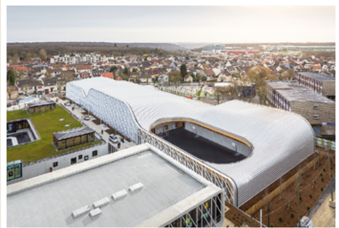
Oben: Ein Dach mit Hebungen und Senkungen überspannt kurvenreich das 130 m lange und 40 m breite Gebäude der neuen städtischen Sportanlage in Clamart bei Paris (Frankreich). Hohlkasten-Träger aus Furnierschichtholz bilden die hochtragfähige Struktur des gitterartigen Tragwerks.
