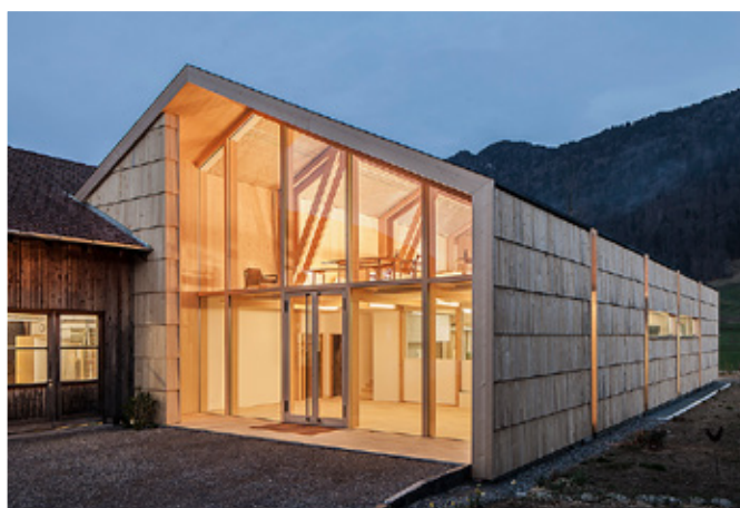
Links: Werkstatt und Ausstellungsraum der Tischlerei Mohr im Bregenzerwald mit einem „BauBuche“-Dachtragwerk wurden im Juli 2015 mit dem Vorarlberger Holzbaupreis ausgezeichnet
